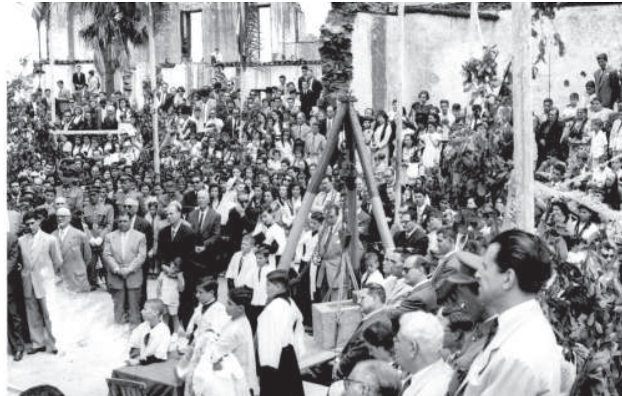
El 24 de julio de 1955 se procedió a la colocación de la primera piedra del nuevo Santuario del Carmen.
