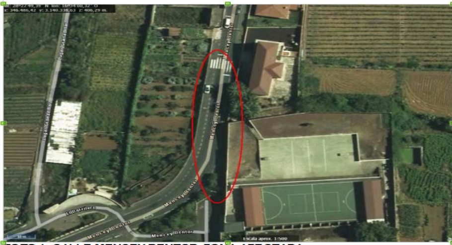
FOTO 1: CALLE MENCEY BENTOR. ZONA AFECTADA
