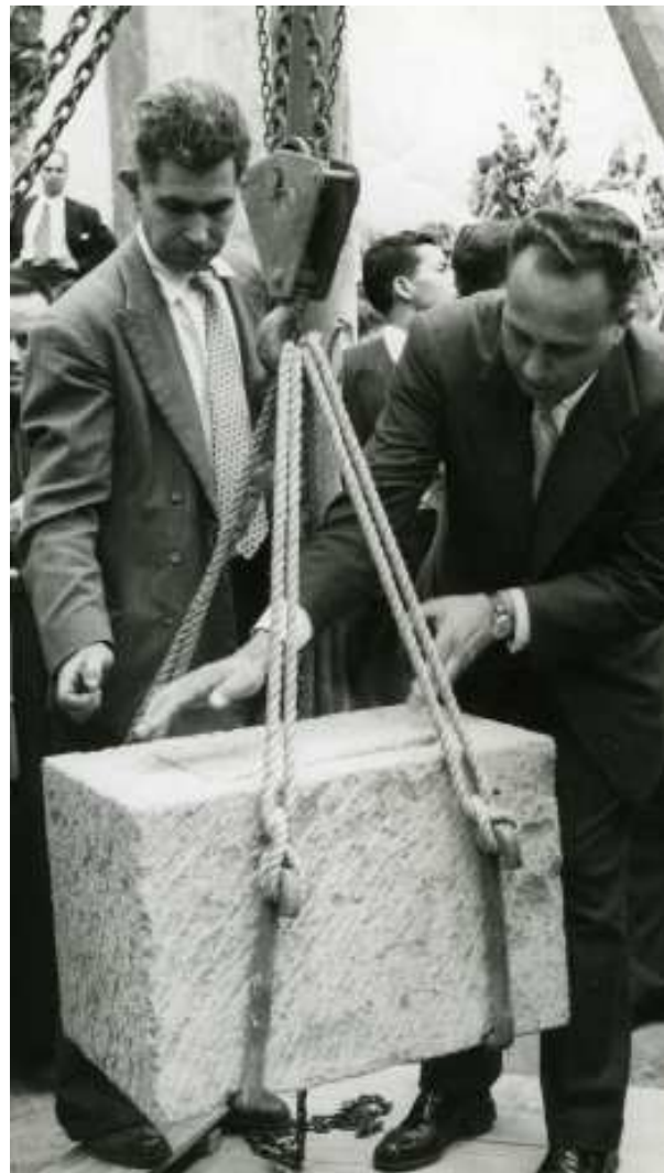
Domingo Luis en el acto de colocación de la primera piedra.
