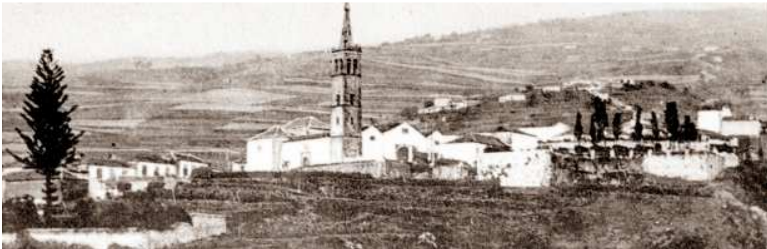
Vista general de Realejo Alto.
