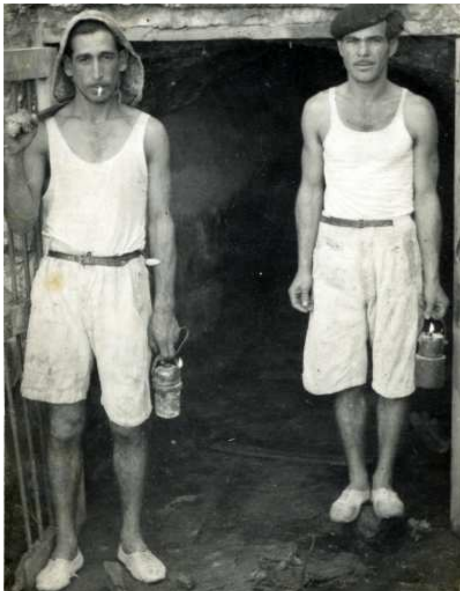
Trabajadores de la galería «Los Beltranes».
