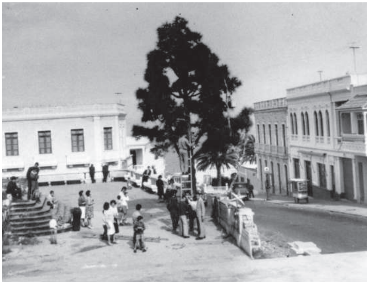
Algunos concejales, como Cristóbal Borges apostaban por el barrio de San Agustín, debido sobre todo a su condición de nexo entre ambos municipios.
