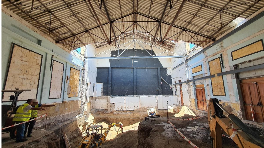
FOTO DEL DESMONTE INTERIOR PARA EL SEMISOTANO.
