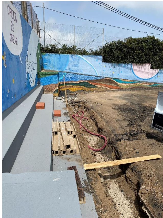
FOTO EN LA QUE SE OBSERVA EL LATERAL DE LA CANALIZACIÓN DE ENDESA. DURANTE LA EJEUCIÓN DE LA OBRA
