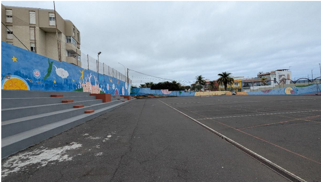
FOTO DE LA CANALIZACIÓN AEREA DE BAJA TENSIÓN EXISTENTE.
