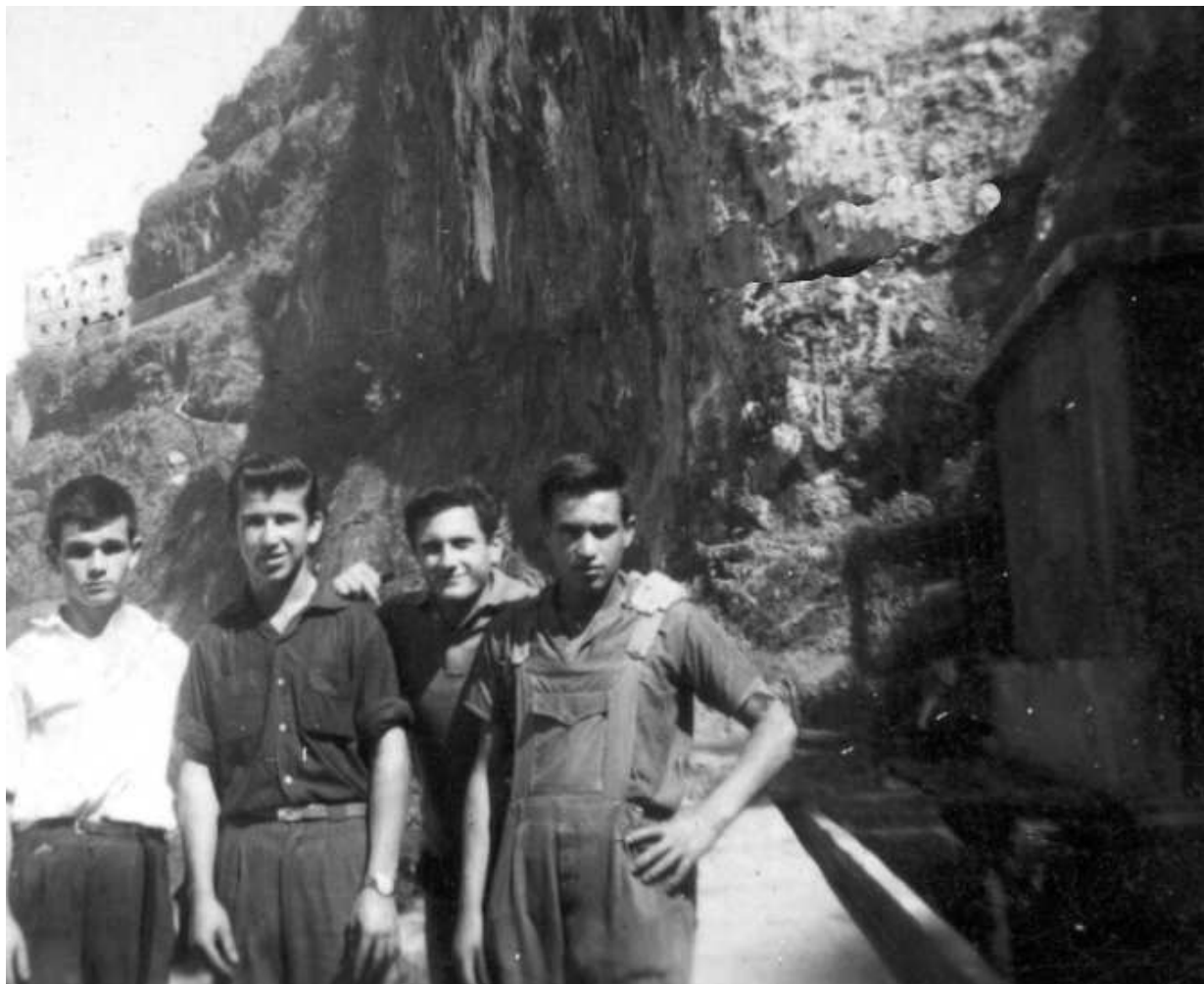
Trabajadores en el elevador de aguas de La Fajana.
